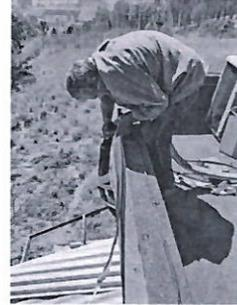
Cambio de mangueras que conectan el compresor con el mini split
